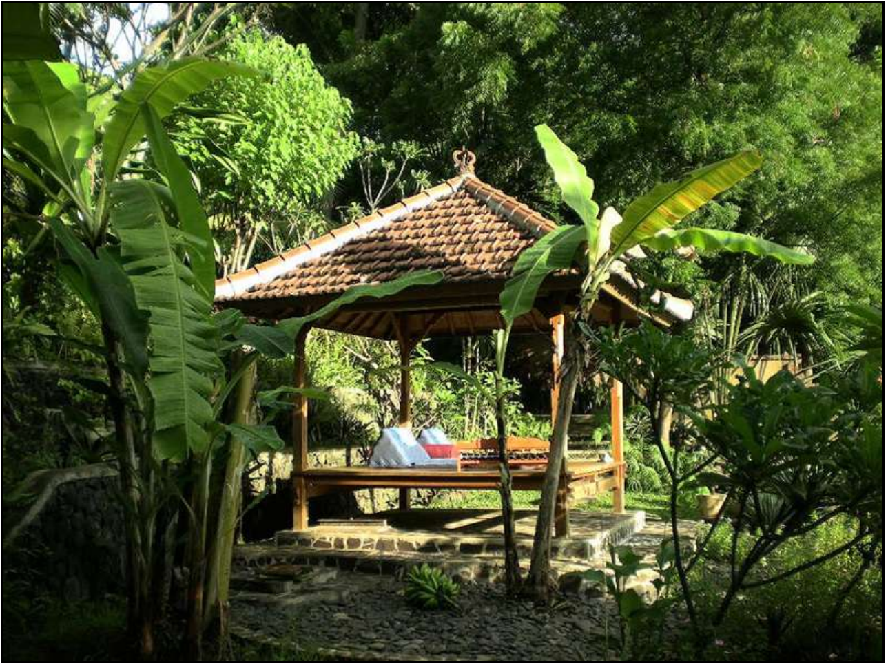
Bale Bengong (Gazebo)
